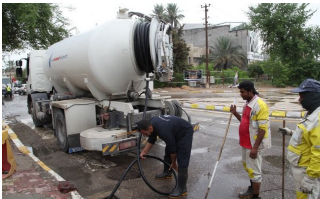
تصريف مياه الأمطار
