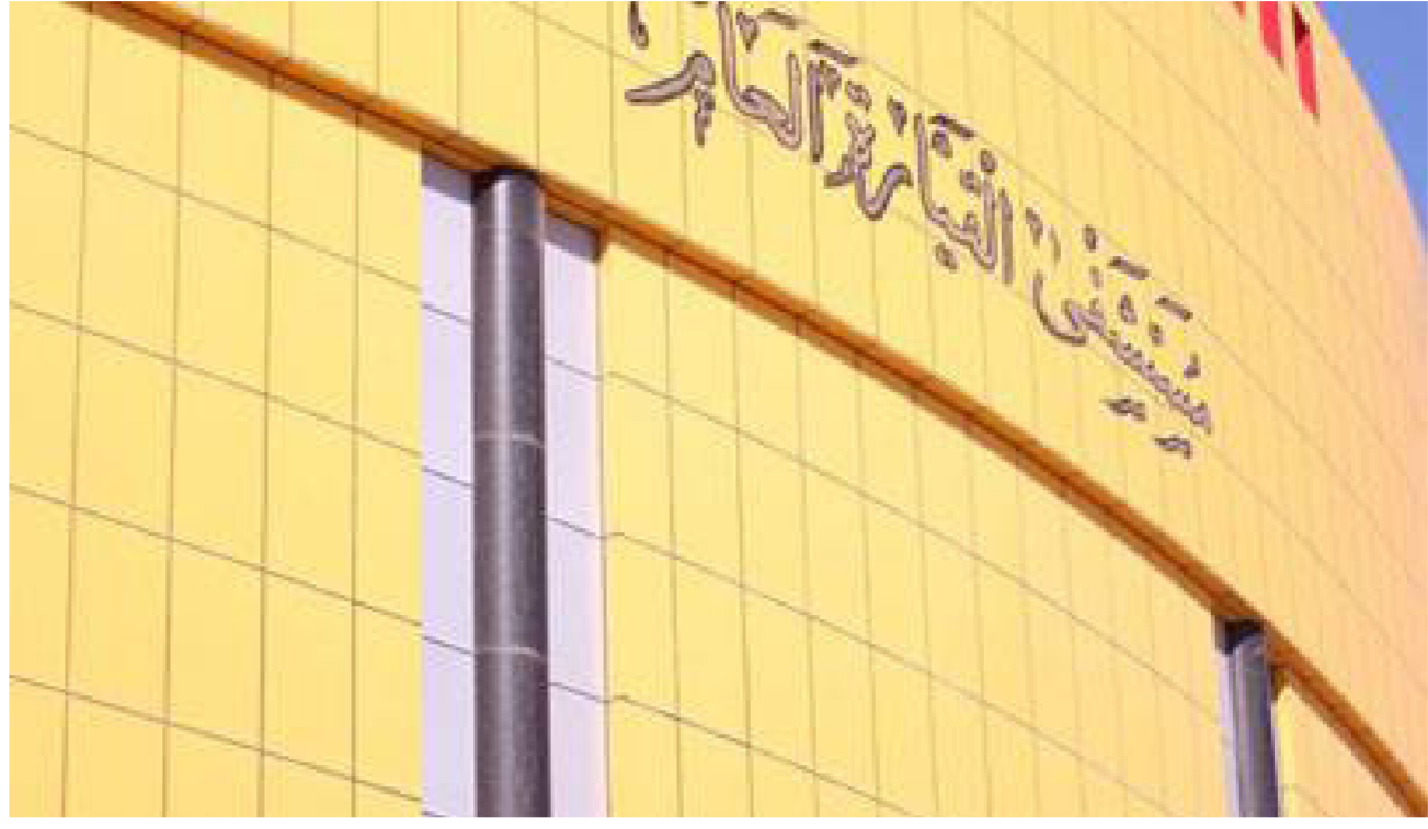
مبنى مستشفى القيارة
