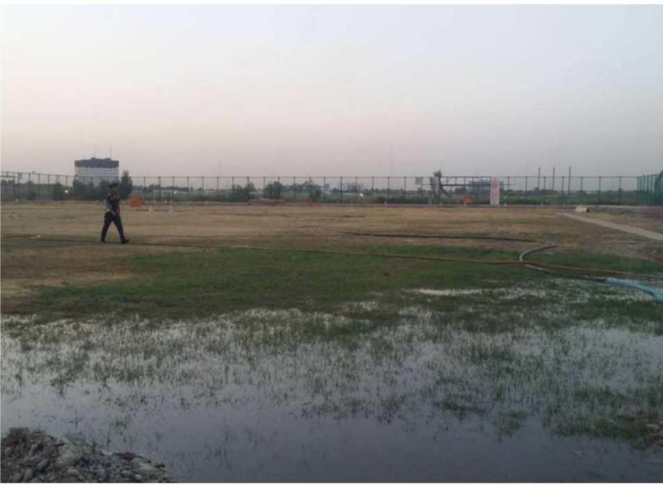
بدء الأعمال في ملعب المدينة الشبابية "عدسة: الصباح الجديد"
