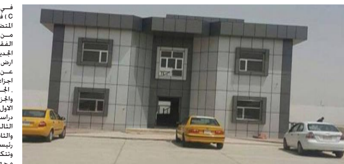
الصب الجاهز لبناء المستوصفات والمدارس
