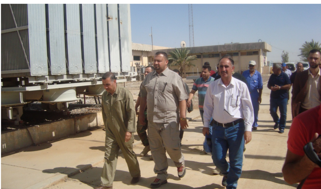
إحدى المحطات الكهربائية في الأنبار
