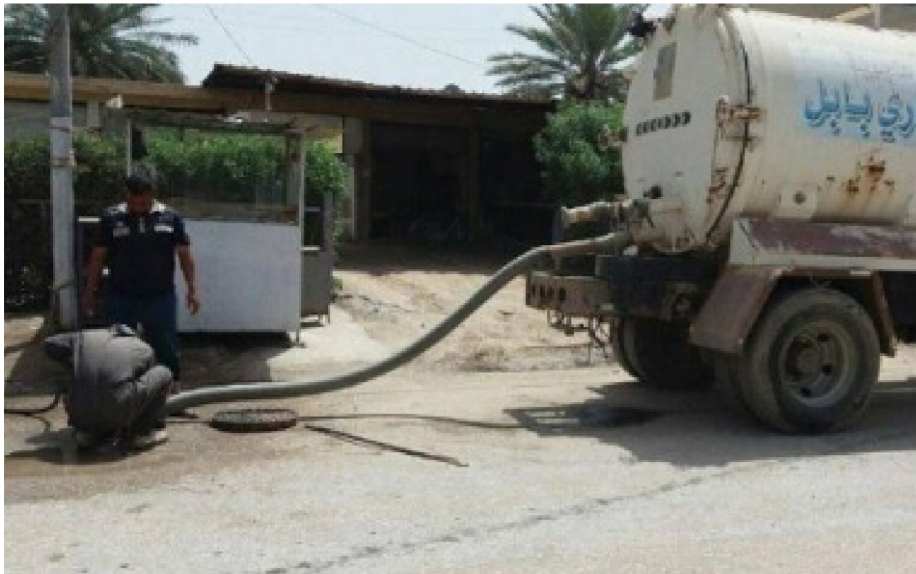
صيانة الطرق وشبكات الصرف الصحي
