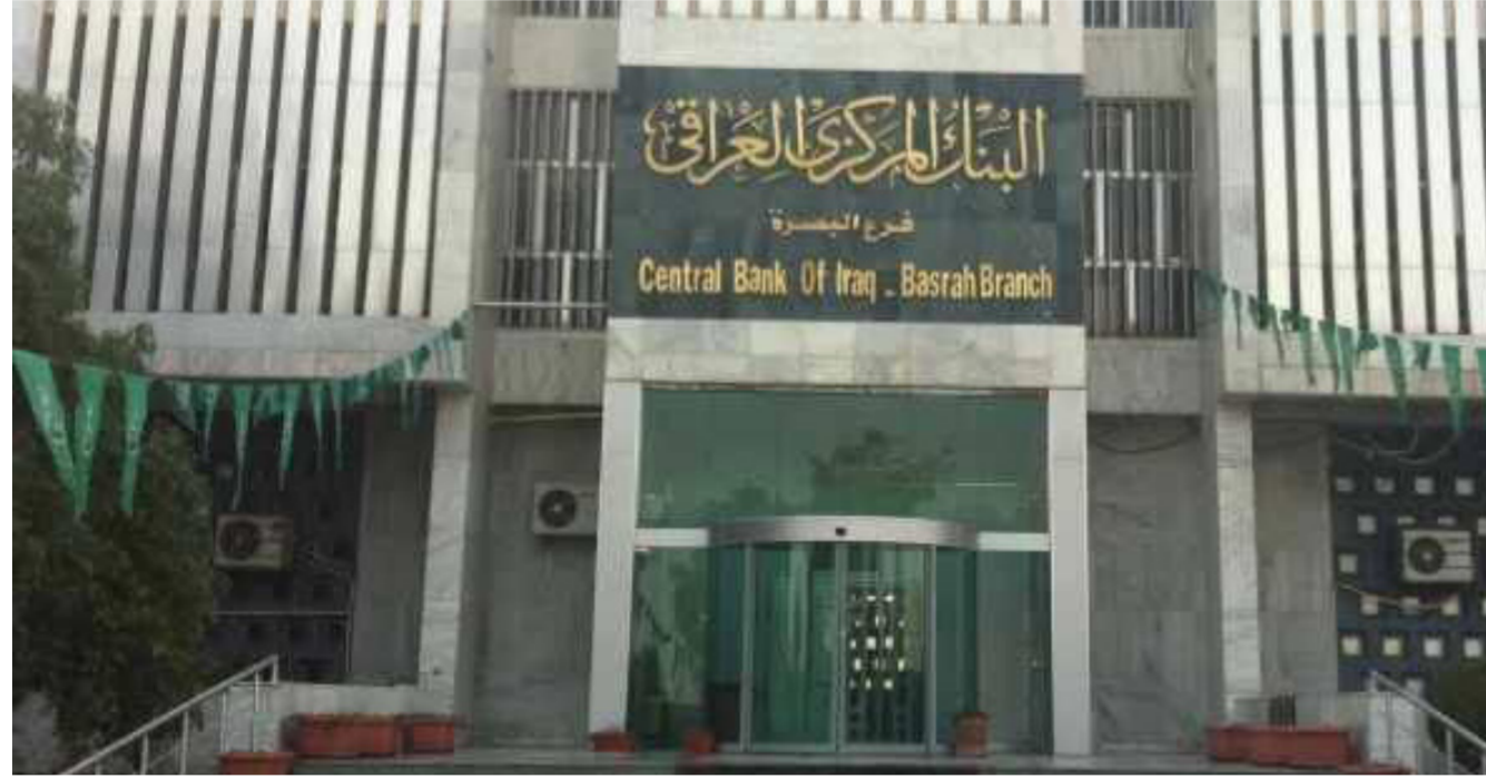
واجهة مبنى احد فروع البنك المركزي
