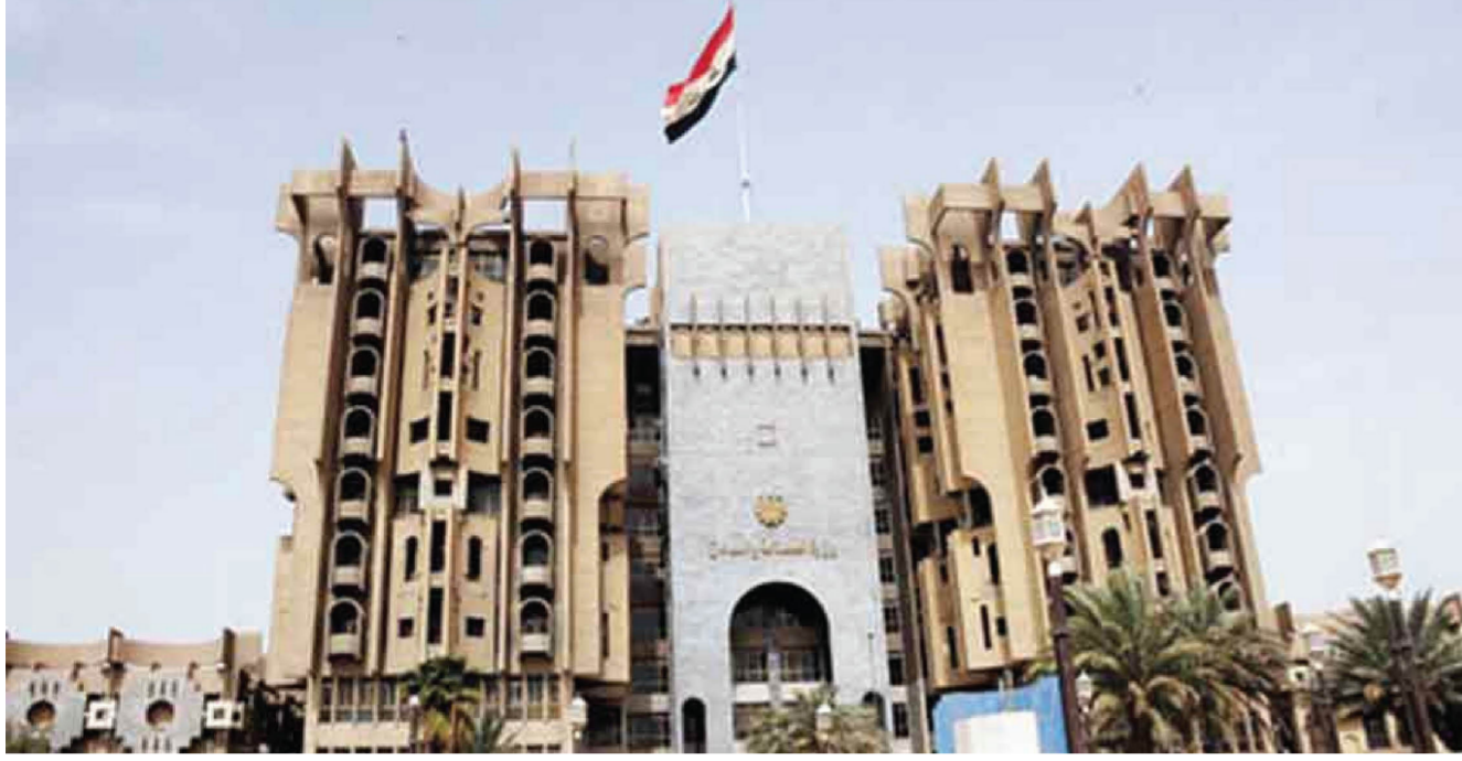
واجهة مبنى وزارة الصناعة والمعادن
