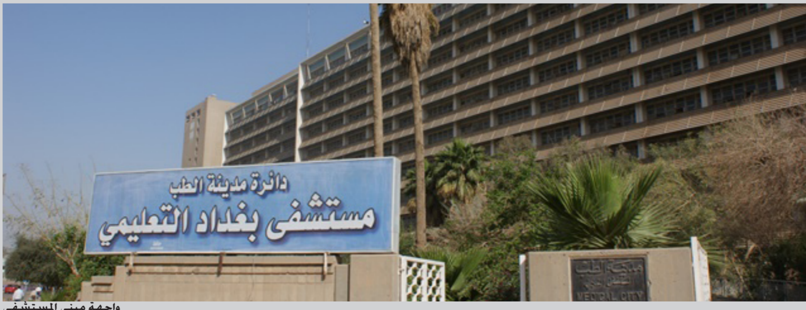
واجهة مبنى المستشفى
