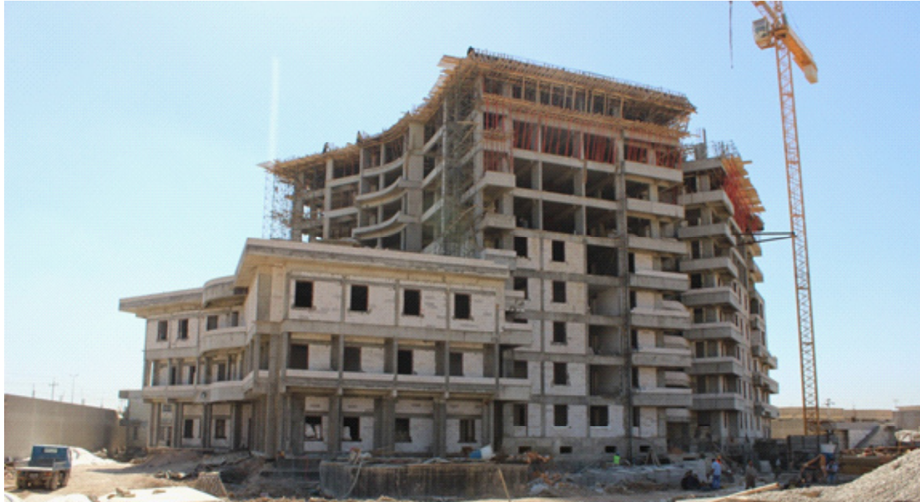
جانب من أحد مشاريع "الإعمار الهندسي" لصالح وزارة الداخلية
